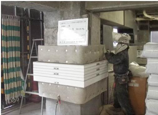
免震装置への耐火被覆の設置
