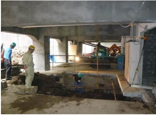
基礎梁補強のための掘削状況
