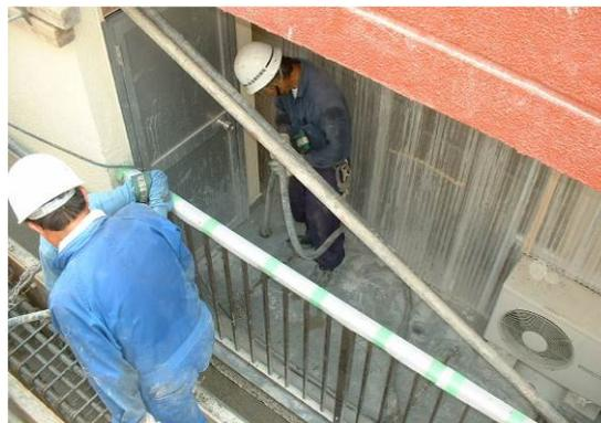
写真 1.6 増設スラブコンクリート打設
