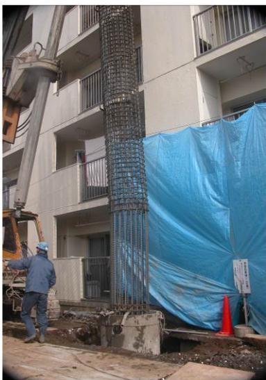
写真 1.3 杭施工状況
