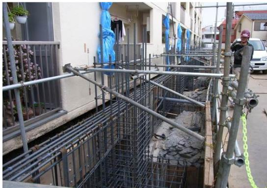
写真 1.4 外付けフレーム下部配筋状況
