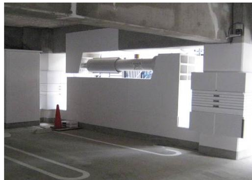
免震装置と減衰装置の設置状況
