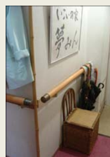
住戸内に手摺の設置
