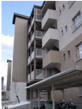
増築された廊下（ブリッジ）とエレベーターシャフト部分の外観
