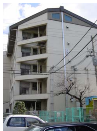
妻側から見たところ (左半分が増築部分)
