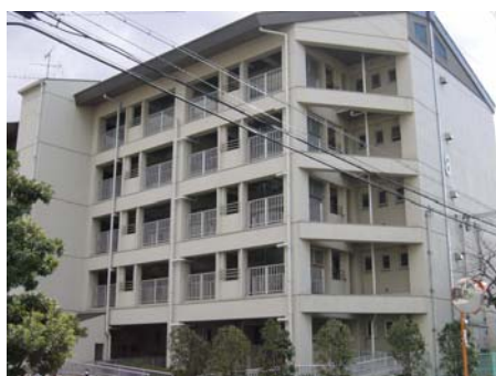
増築部分を北側から見たところ
