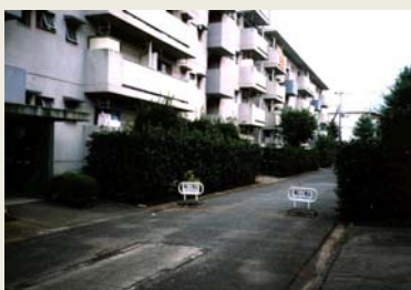
団地内通路改修前
