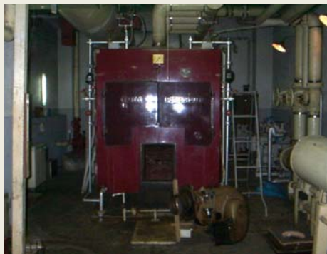
機械室として使用されていたスペース
