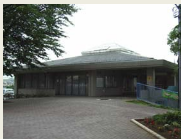
新築した自治会館（集会所）
