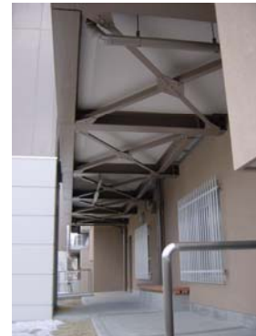
増築された廊下（ブリッジ）を見上げる。増築廊下は鉄骨造
